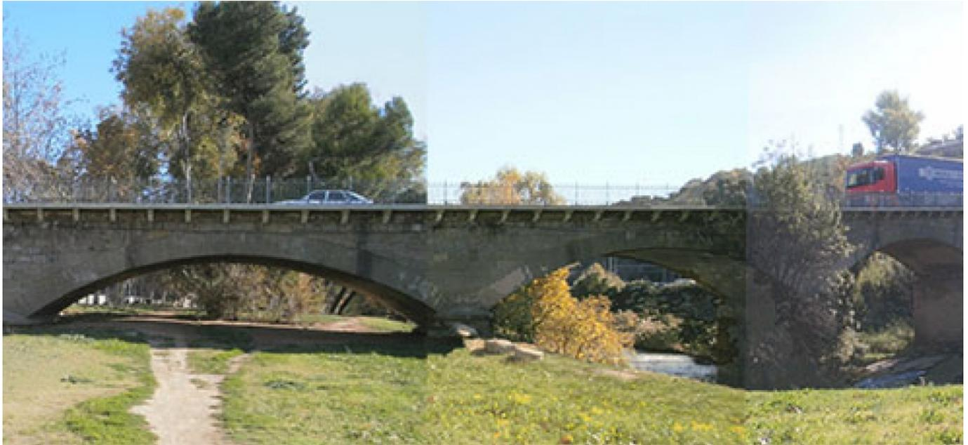
Ensanchamiento del tablero de un puente en arco existente en la localidad de Manresa (España).
